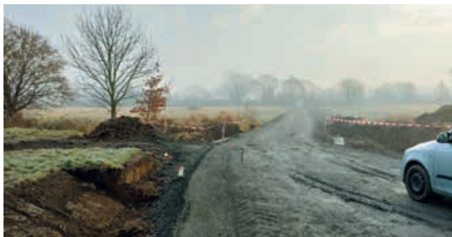
Výstavba zpevněné polní cesty z Košetky do Proskovic
