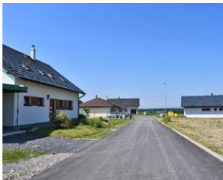
Odkanalizování ul. Slunečná
