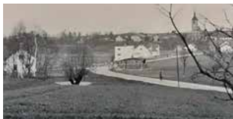
Rozcestí na Košatku s celnicí (dřevěná bouda uprostřed)
