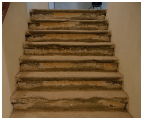
Původní pískovcové schody
