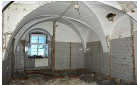
Nezvyklý pohled na bývalé i budoucí WC bez příček
