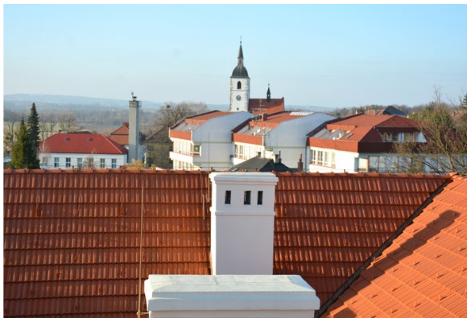
Panorama s novou střešní krytinou
