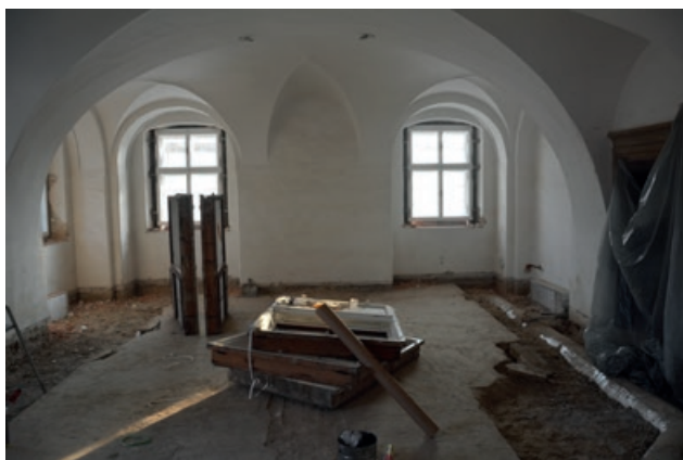
Rekonstrukce obřadní síně
