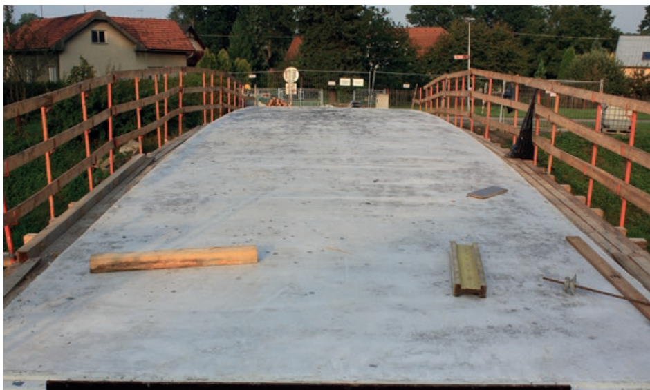
Rekonstrukce mostu přes Ondřejnici na Horním konci
