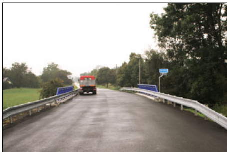
Opravený most přes Machůvku
