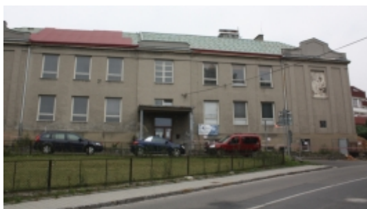
Nová střecha na staré školní budově
