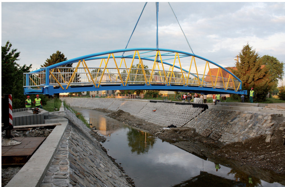
Montáž nového mostu u „hasičárny“
