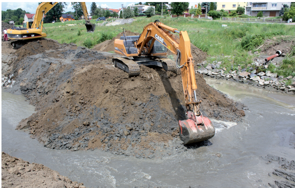
Zprůtočnění nového koryta řeky Ondřejnice
