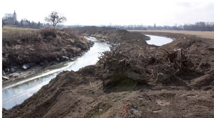
Nové koryto řeky Ondřejnice
